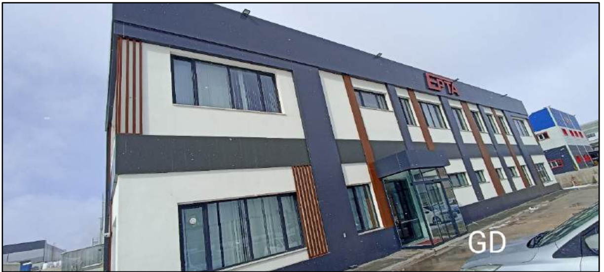
Şekil 4 EPTA Bina Görseli
