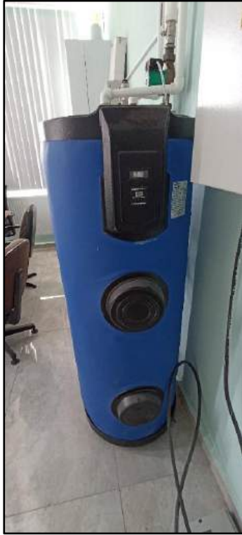
Şekil 28 Boyler tanki ve etiket bilgisi
