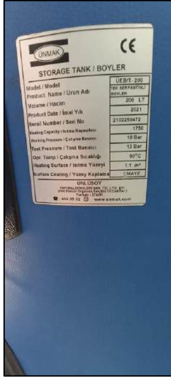
Şekil 28 Boyler tanki ve etiket bilgisi
