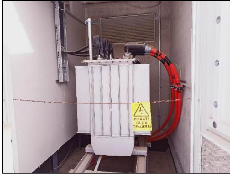
Şekil 69 400 kVA Trafo 2
