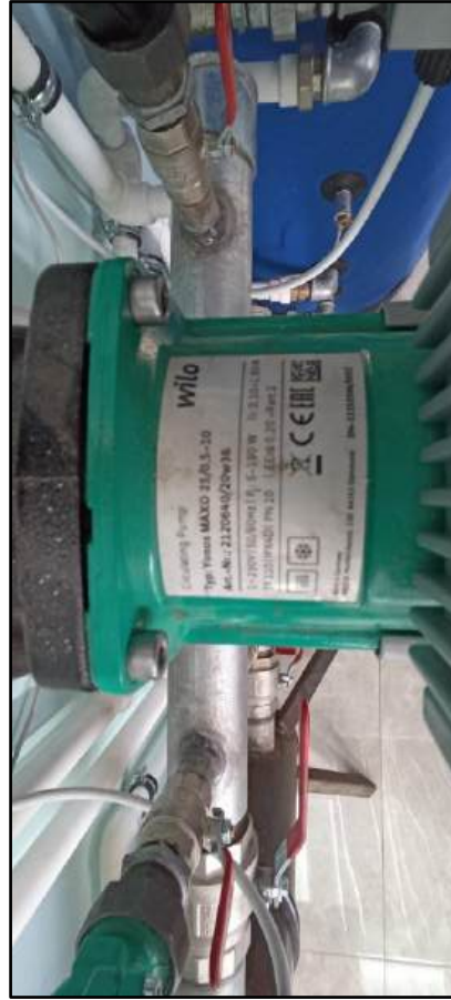
Şekil 29 Isıtma sistemi Pompa Fotoğrafi ve Motor Bilgisi
