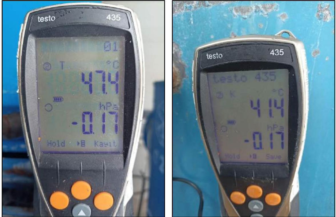
Şekil 40 Soğutma Kulesi 1 Giriş – Çıkış Suyu Sıcaklık Ölçümü
