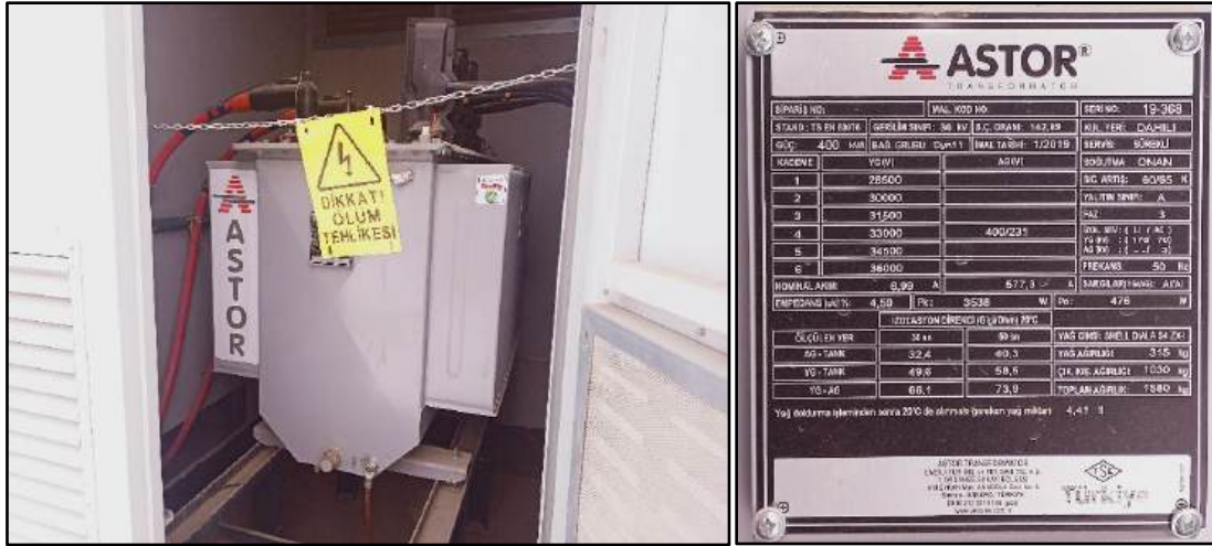
Şekil 67 400 kVA Trafo 1
