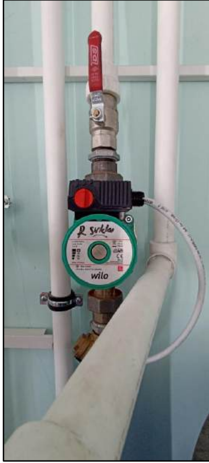
Şekil 29 Isıtma sistemi Pompa Fotoğrafi ve Motor Bilgisi
